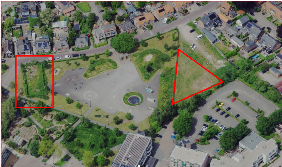
Figuur 2.1. Vogelvluchtaanzicht bestaande situatie d.d. 29 mei 2023 (bron: Streetsmart Cyclomedia).
