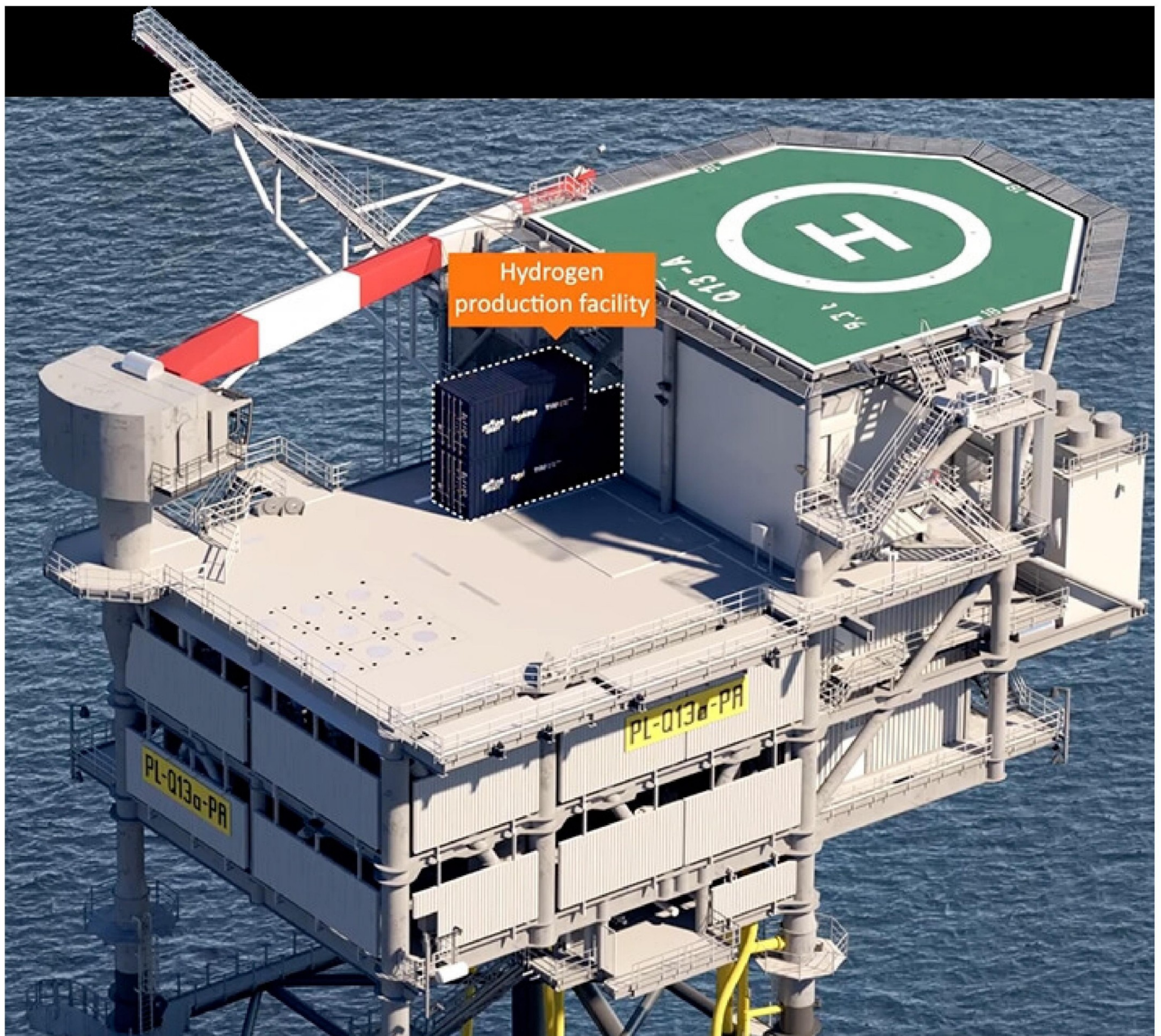
PosHYdon installatie: groene waterstof uit zeewater.
