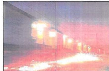
Figuur: Het bijlijpen van spoorstaven.
