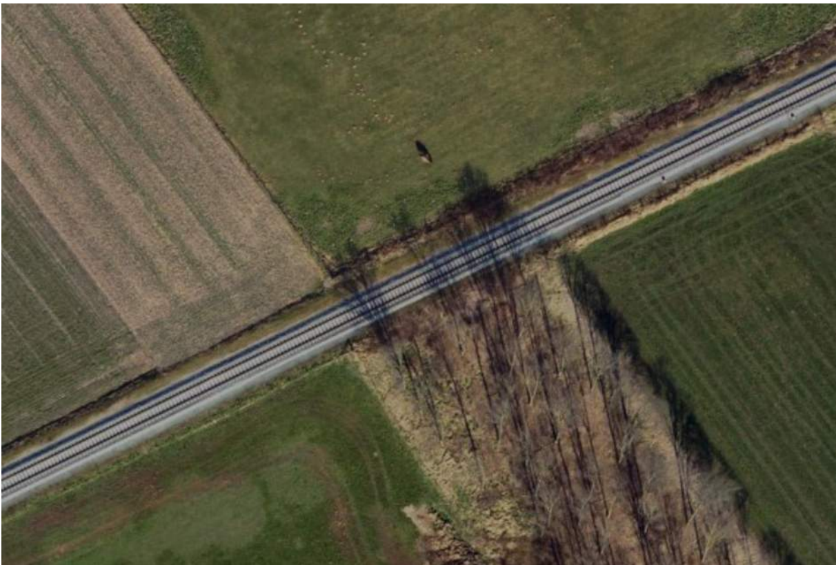
Figuur 42: Houtwal ten westen van het Stilliwald naast de tijdelijke bouwweg richting de Frieslandweg
