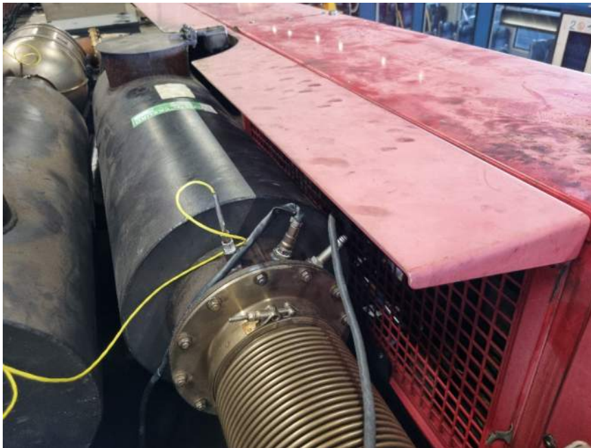
Figuur 3-1: De NO x /O 2 , NH 3 , en temperatuursensor, zoals deze gemonteerd waren in de uitlaat van de motor voor de demper op het dak van de trein.
