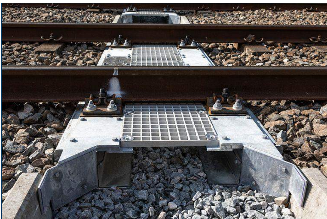
Figuur 4.3: Voorbeeld van een dwarsligger faunapassage voor amfibieën en reptielen. Uit onderzoek blijkt dat dassen ook gebruik maken van deze passage (al is deze naar verwachting minder geschikt dan de 'standaard' passage die voor das gebruikt wordt).
