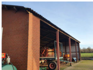
foto 2 - ter plaatse machineberging
