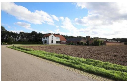
Zicht op het erf vanaf de Broekstraat met rechts de veeschuren en centraal de bestaande woning.
