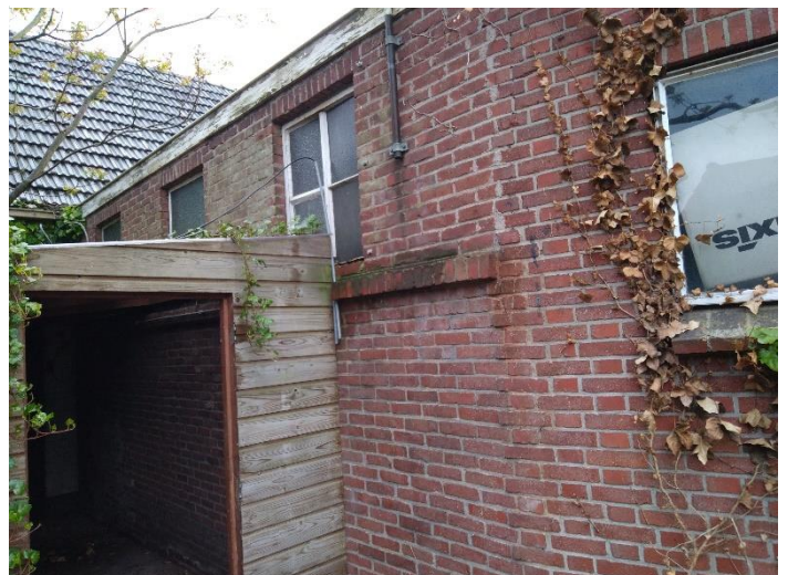
Figuur 33 Achtergevel wasplaats
