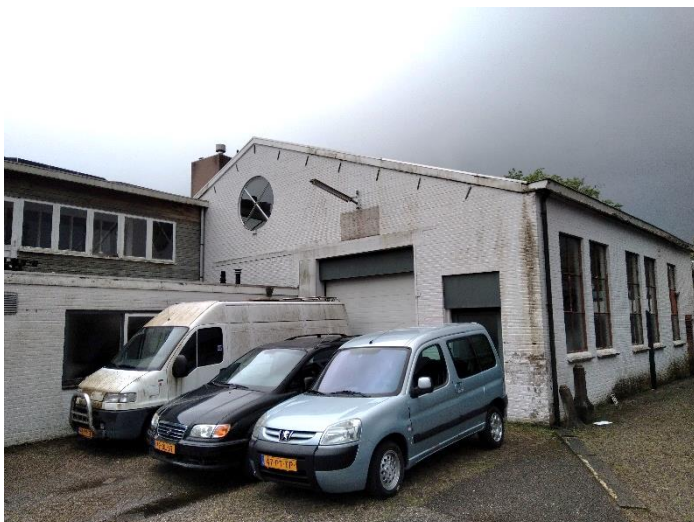
Figuur 39 Voor- en zijgevel garage
