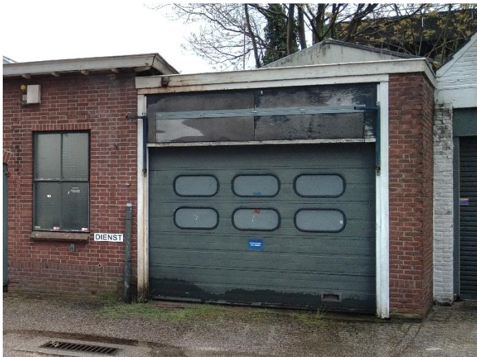
Figuur 34 Voorgevel wasplaats
