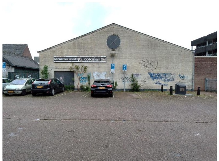
Figuur 40 Achtergevel garage
