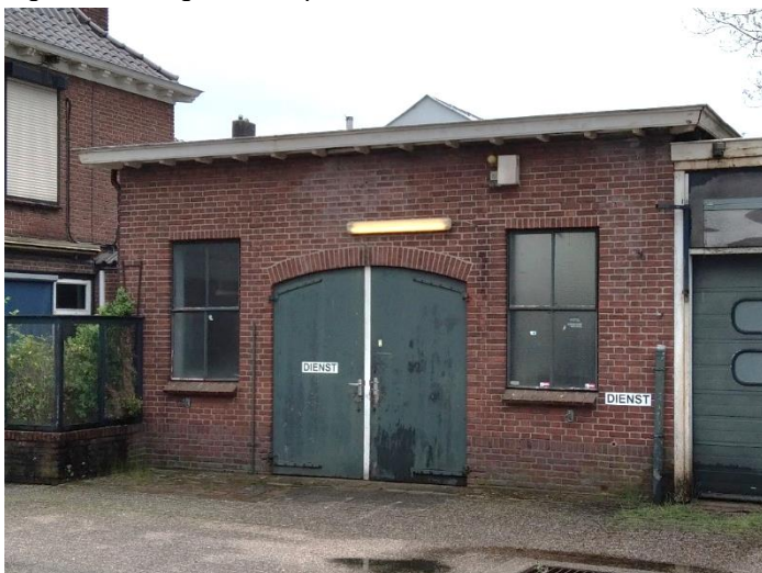
Figuur 32 Voorgevel werkplaats I
