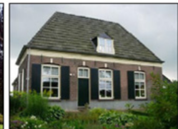
schilddak (voorbeelden van mogelijke afgeleiden van een zadeldak)
