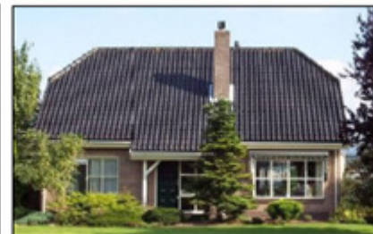
afgewolfd zadeldak (voorbeelden van mogelijke afgeleiden van een zadeldak)
