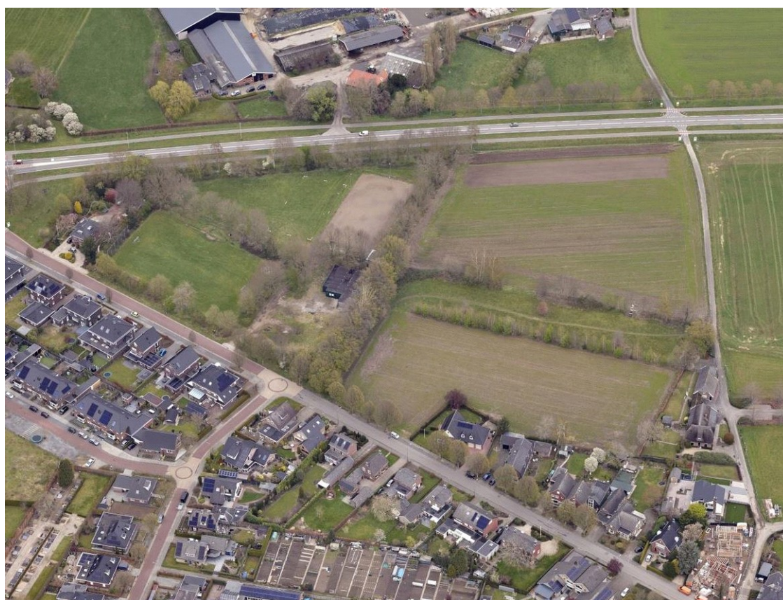
Luchtfoto plangebied richting het noorden
