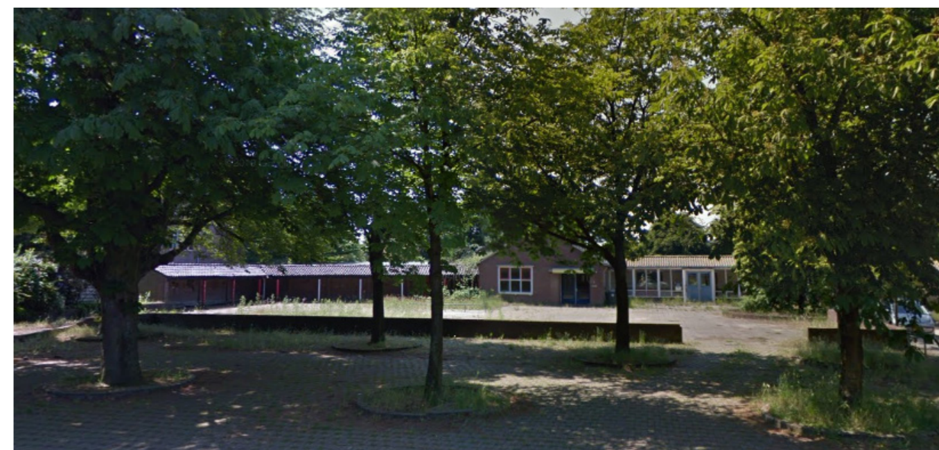
Voormalig schoolgebouw Henricusschool (Bron: Google 2016)
