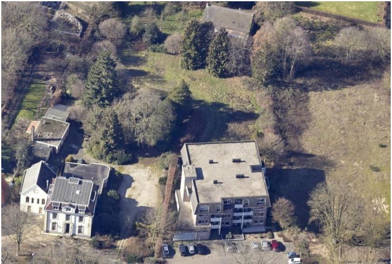
Luchtfoto huidige situatie met linksonder Huize Lamsweerde (bron: Slagboom en Peeters luchtfotografie)
