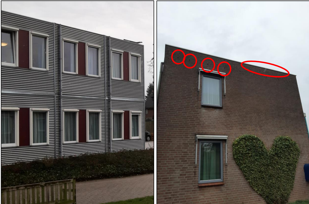
Figuur 3 Het oostelijke gebouw (links) is afgewerkt met metalen golfplaten rondom het gehele gebouw. Door het ontbreken van grip en aansluitend spleetvormige ruimtes worden verblijfplaatsen van gebouwbewonende vleermuizen dan ook niet in het oostelijke gebouw verwacht. Het westelijke gebouw (rechts) met daarentegen gemetselde gevels met rondom een aanwezige spouw is toegankelijk voor gebouwbewonende vleermuissoorten middels open stootvoegen en mogelijk ook via de daktrim.
