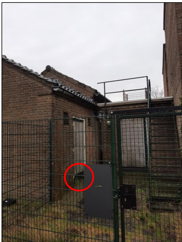
Figuur 6 Het bijgebouw van het westelijke gebouw in het projectgebied is mogelijk toegankelijk voor steenmarter en geschikt als verblijfplaats
