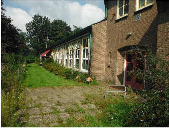
Vanuit oostelijke richting nabij boring 9
