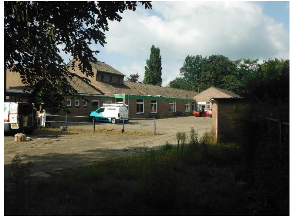
Vanuit oostelijke richting nabij boring 10
