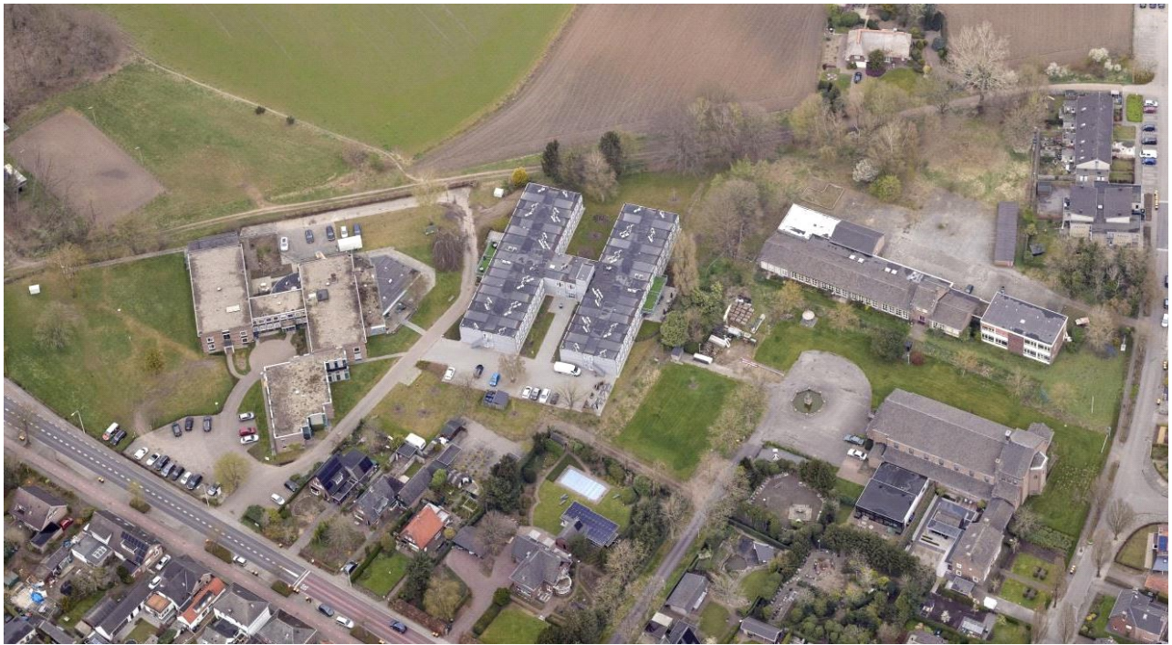
Luchtfoto plangebied richting het noorden
