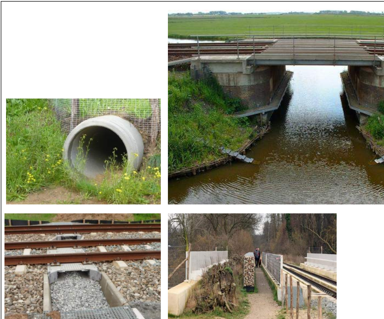
Figuur 3.1. Verschillende vormen van faunapassages. Met van links naar rechts en van boven naar beneden voorbeelden: holle buis constructie; een looprichel; Dwarzsligger FaunaPassage; en groenstrook parallel aan spoor.
