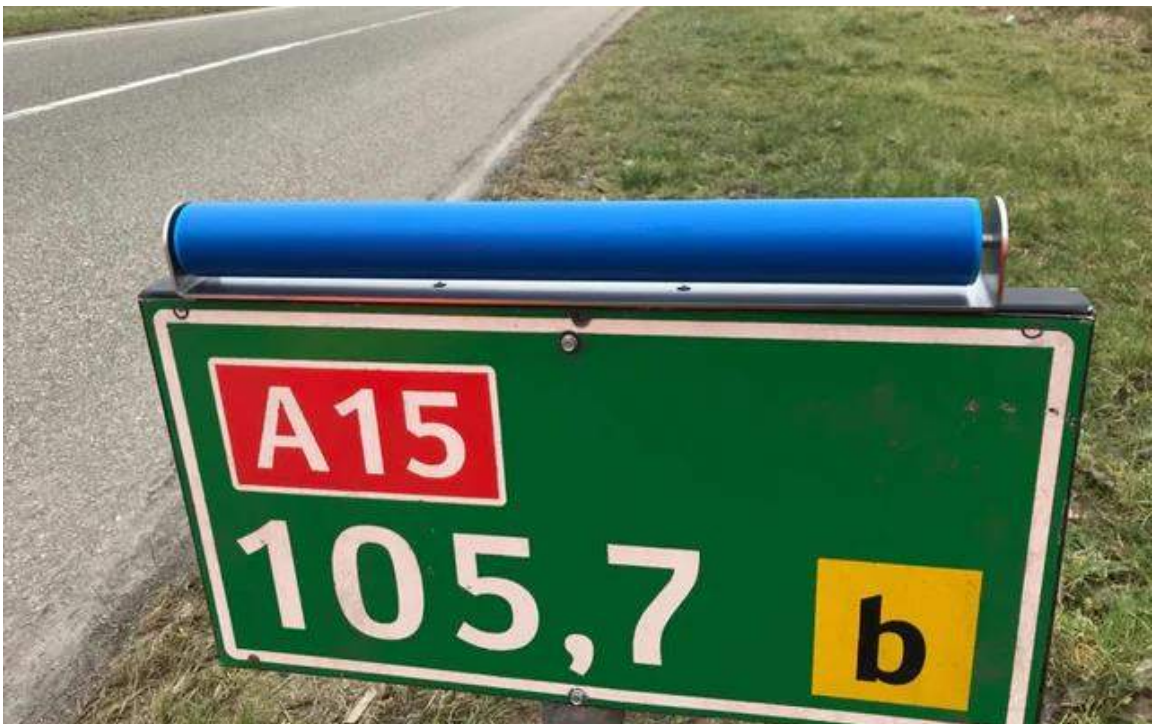
Figuur 6.1. Hectometerpaal van de A15 met roller. Een dergelijke rollerconstructie is ook werkzaam voor borden langs het spoor (bron: RWS).
