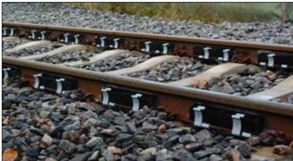
Figuur B1-2 Voorbeeld van de bronmaatregel raildempers.
