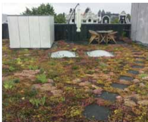
Boven: een voorbeeld van een extensief sedumdak. Onder: een voorbeeld van een natuurdak.
