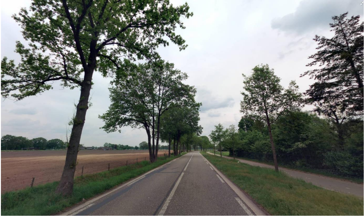
Figuur 15: oudere bomen aan de westzijde kunnen niet behouden worden bij een wegverbreding.
