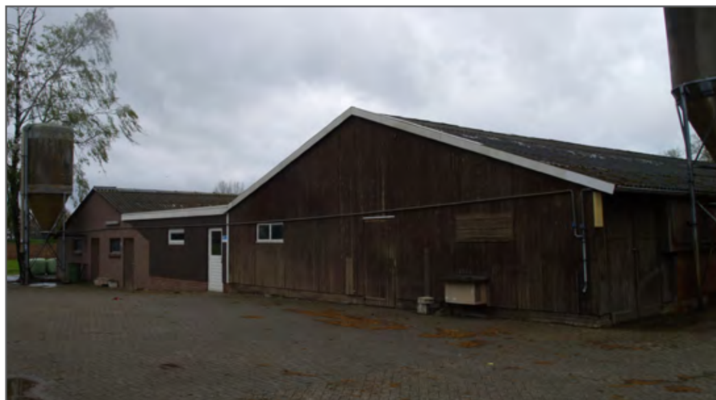
Foto: Te slopen kippenschuren
