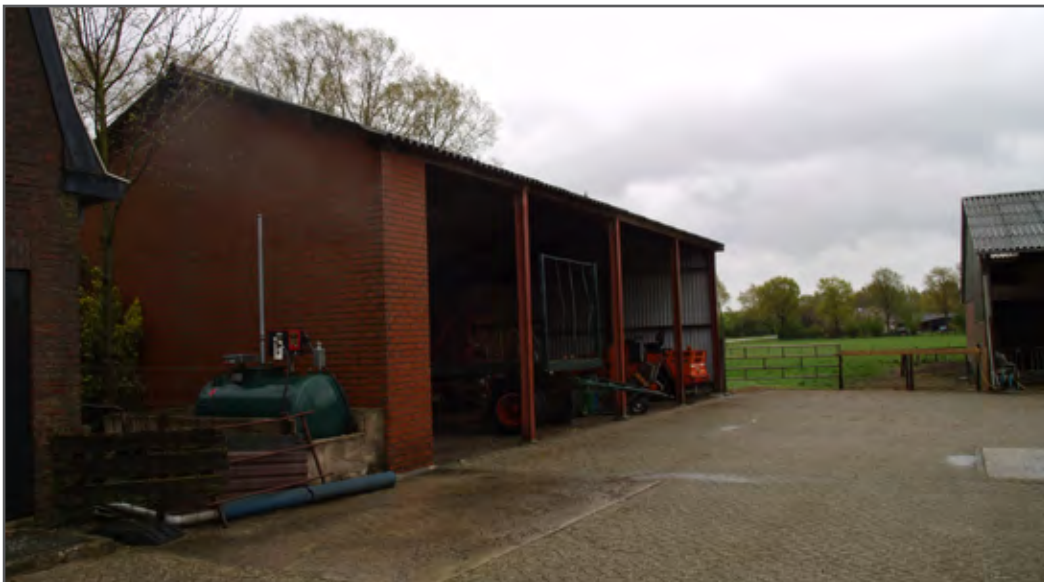
Foto: Te slopen schuur
