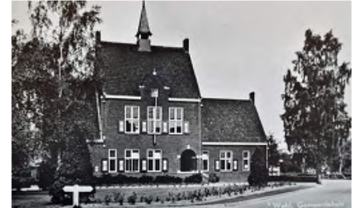
Nadat het oude Raadhuis te bouwvallig was geworden (in 1935 werd na bouwkundig onderzoek het gebouw ontruimd), liet men in 1937-'38 een nieuw gemeentehuis bouwen aan het huidige Beatrixplein.
