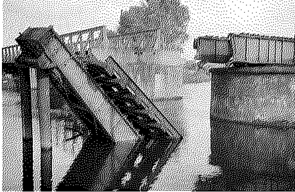
Over de Oude IJssel lag vanaf de aanleg van de spoorlijn een spoorbrug in de vorm van een stalen draaibrug. Deze brug is in 1940 opgeblazen en vlak na de Tweede Wereldoorlog hersteld en vernieuwd als stalen hefbrug.
