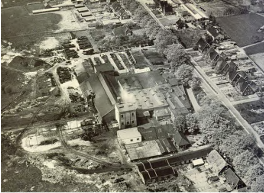
Luchtfoto van de ijzergieterij aan de Keppelseweg vanuit het zuid-oosten gemaakt omstreeks 1965.
