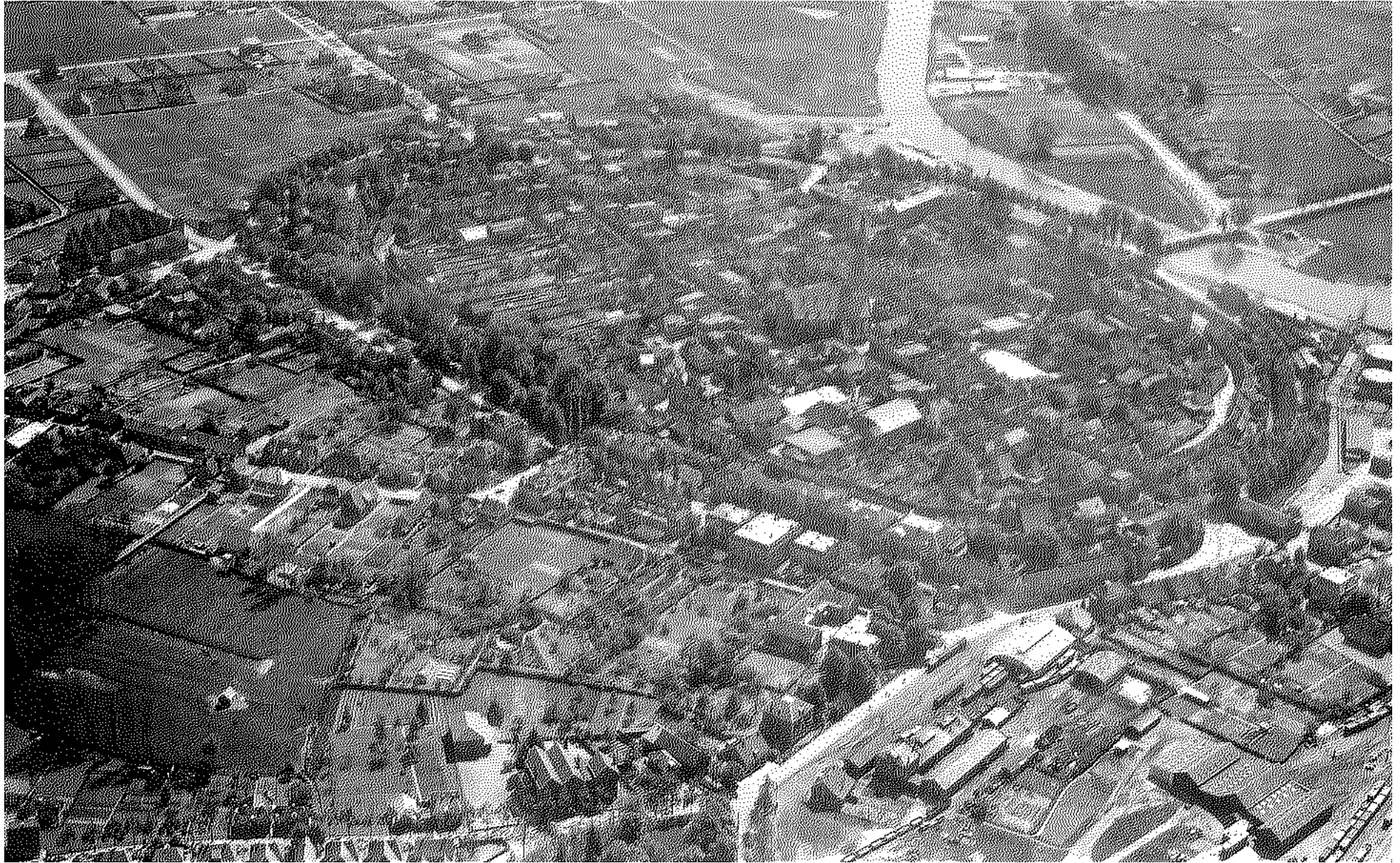
Luchtfoto van Doetinchem uit 1928 vanuit het noorden. Helemaal onderaan het tracé van de Hofstraat, met ten westen daarvan (rechts) de gebouwen van de Tramwegmaatschappij Zutphen-Emmerik. Direct ten noorden (onder) van de binnenstad de lintbebouwing aan de Plantsoenstraat en Dr Huber Noodtstraat.
