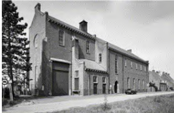
Het in 1935 gebouwde en omstreeks 1950 uitgebreide onderstation van de PGEM op de kruising van de Keppelseweg en de Energieweg.
