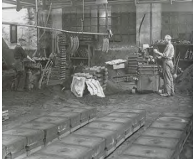
Werknemers van de ijzergieterij zijn bezig met het vormen met behulp van machines. Op de voorgrond liggen de vormkasten en tussen beide werknemers hangen tussenstukken voor pijpleidingen.
