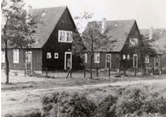
De eerste woningen van De Hoop waren vier houten noodwoningen voor het personeel van de Gelderse Tramweg-Maatschappij uit 1947-'48. Deze 'Oostenrijkse Woningen' werden in losse prefabonderdelen vanuit Oostenrijk geleverd en konden in een paar dagen gebouwd worden. Het pad voor de woningen is nog niet bestraat.
