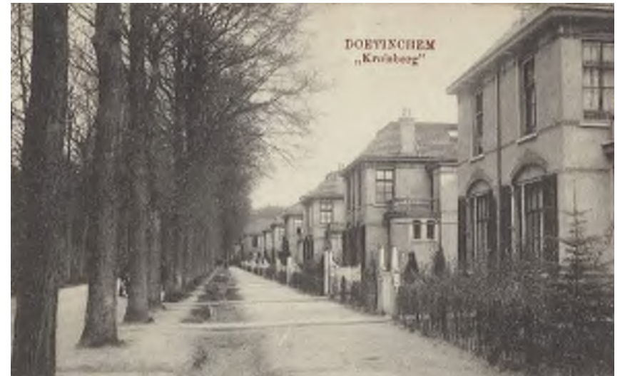
Het lint van dienstwoningen van De Kruisberg aan de Kruisbergseweg, gebouwd in de periode 1899-1912.
