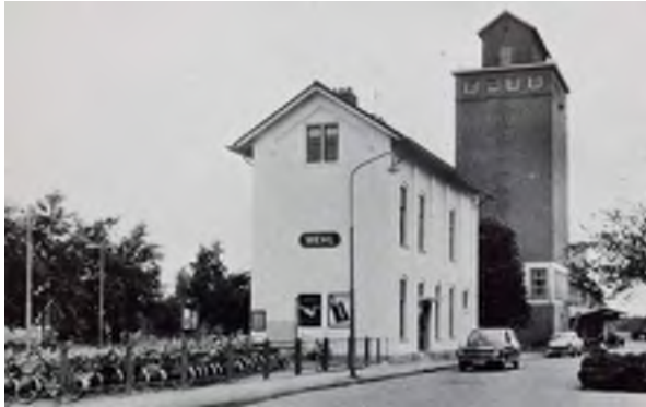
Het uit 1885 daterende en in 1914 met een verdieping verhoogde treinstation van Wehl. Daarachter het gebouw van de Coöp. Landbouw-Handelsvereniging, dat na de Tweede Wereldoorlog werd voorzien van een grote (araan)silo.
