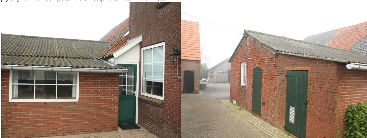
Er zijn geen oude huismusnesten onder de golfplaten van de aanbouw vastgesteld en de golfplaten sluiten goed op elkaar aan.
