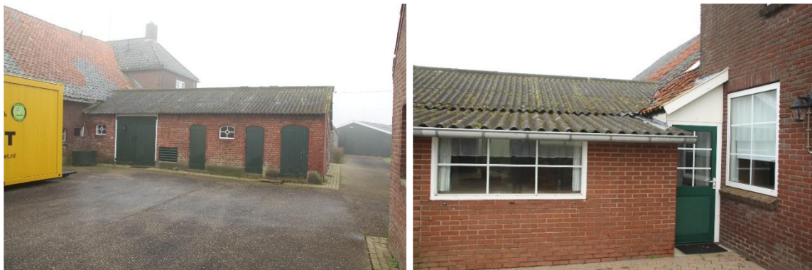
Detailfoto's van de aanbouw (februari 2023).
