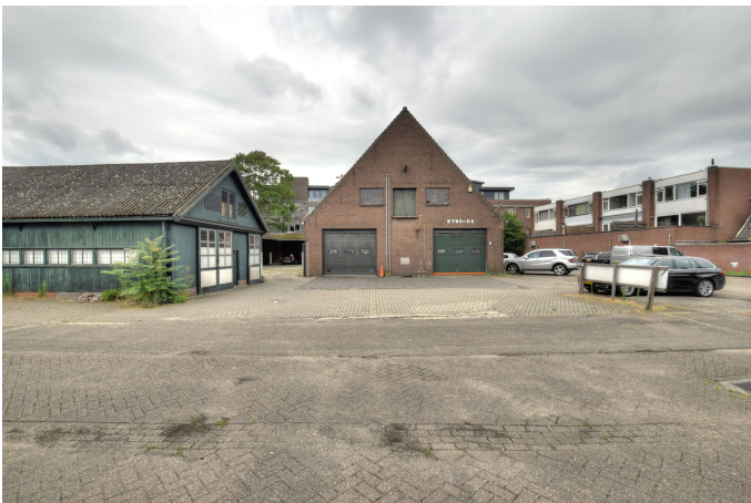
Overzicht van het binnenterrein in westelijke richting, met zicht op de voorgevel van Dr. Huber Noodtstraat 38a. Links daarvan de in 1953 gebouwde timmerloods van aannemer Kolkman.
