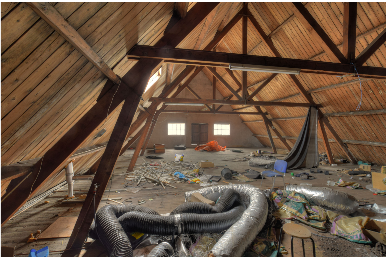
Overzicht van de zolder met kapconstructie richting de voorgevel.
