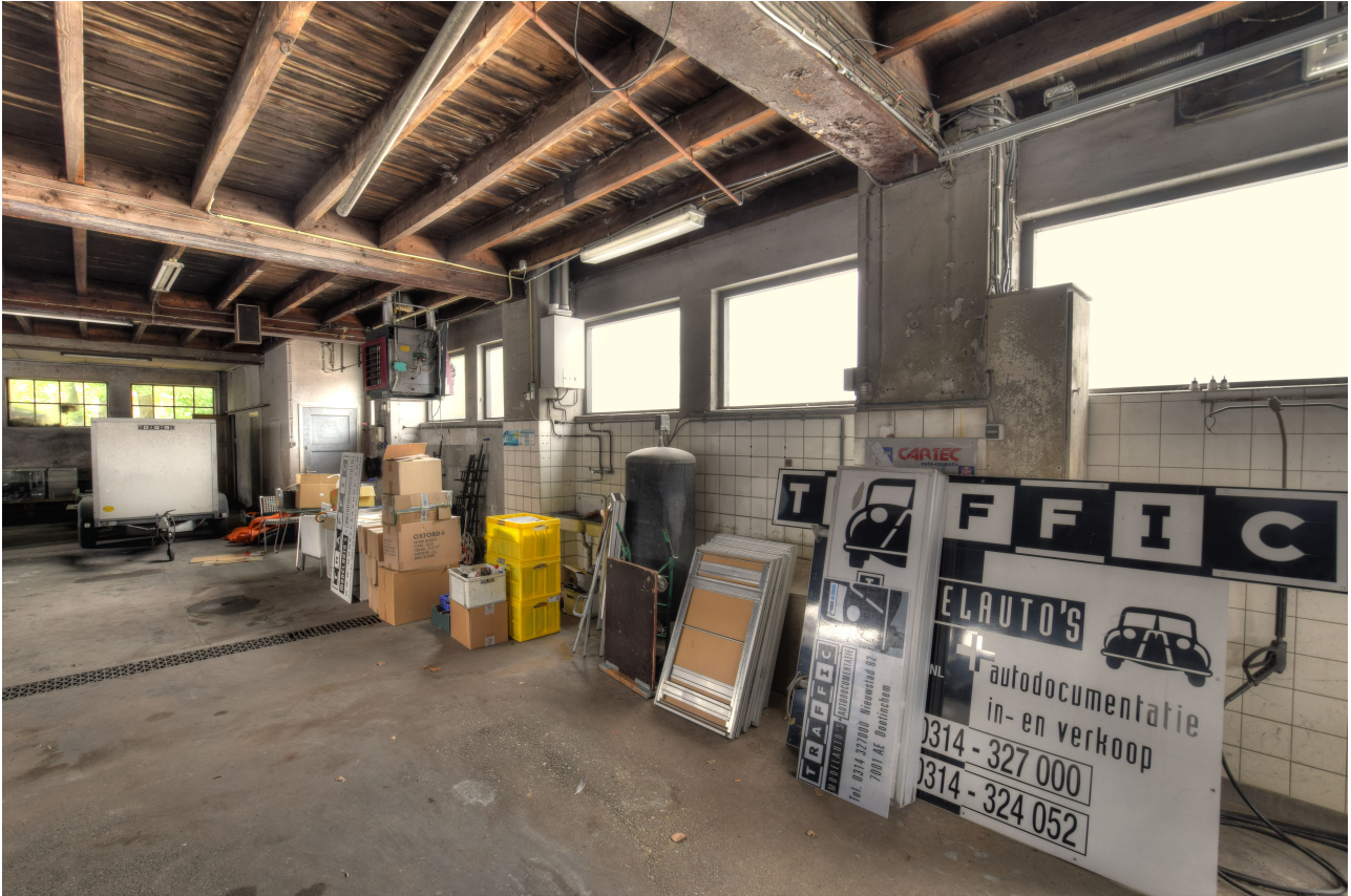
Begane grond van het gebouw in de richting van de rechter zijgevel (noordgevel).
