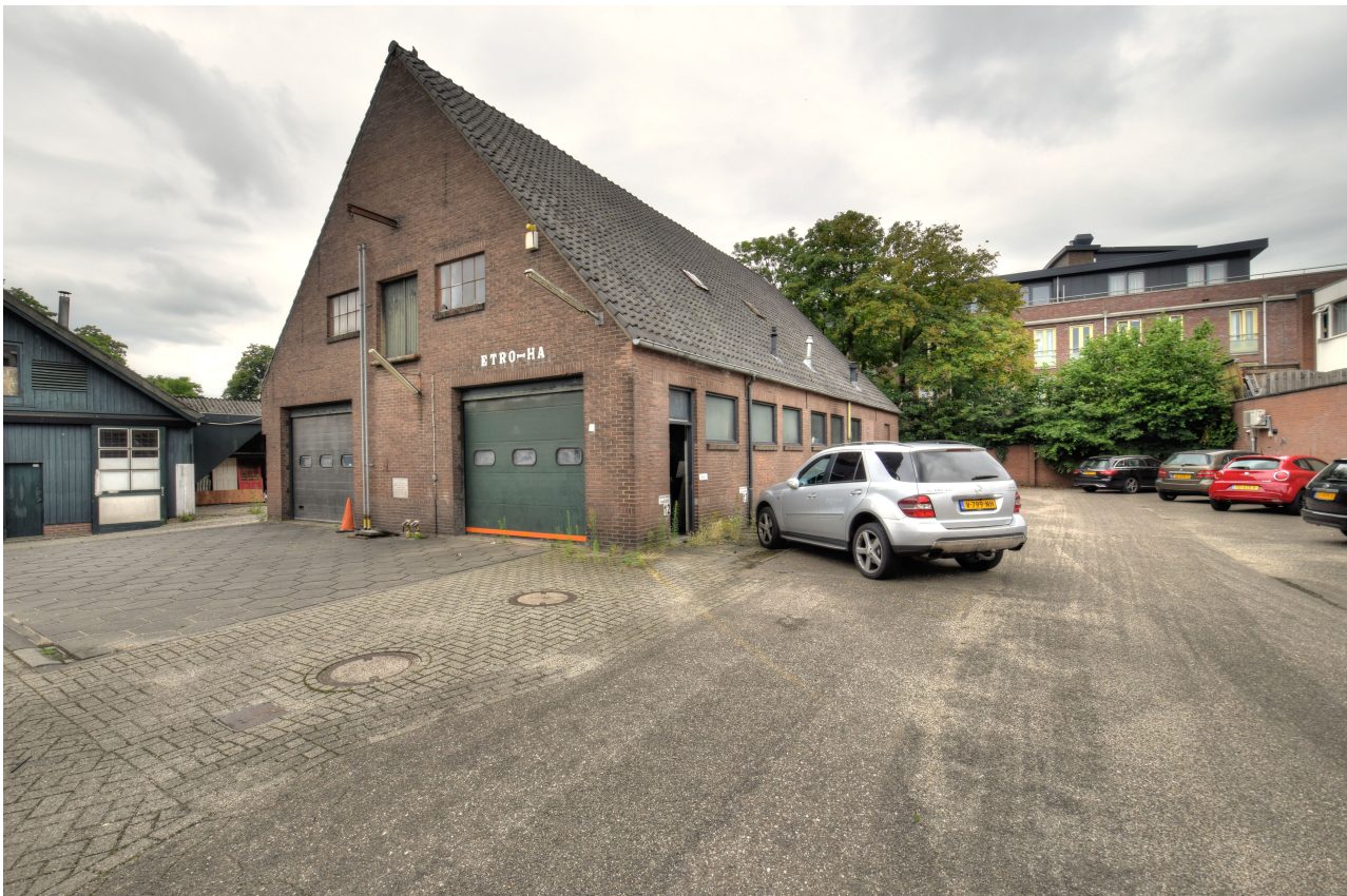
Overzicht van het gebouw vanuit noordoostelijke richting, met zicht op de voorgevel (oostgevel) en rechter zijgevel (noordgevel).
