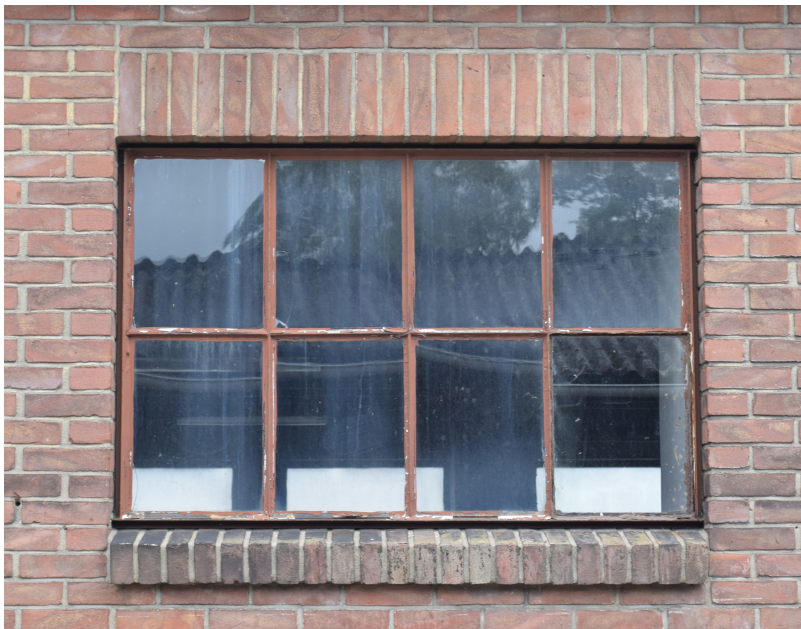
Detail van één van de stalen ramen in de linker zijgevel.
