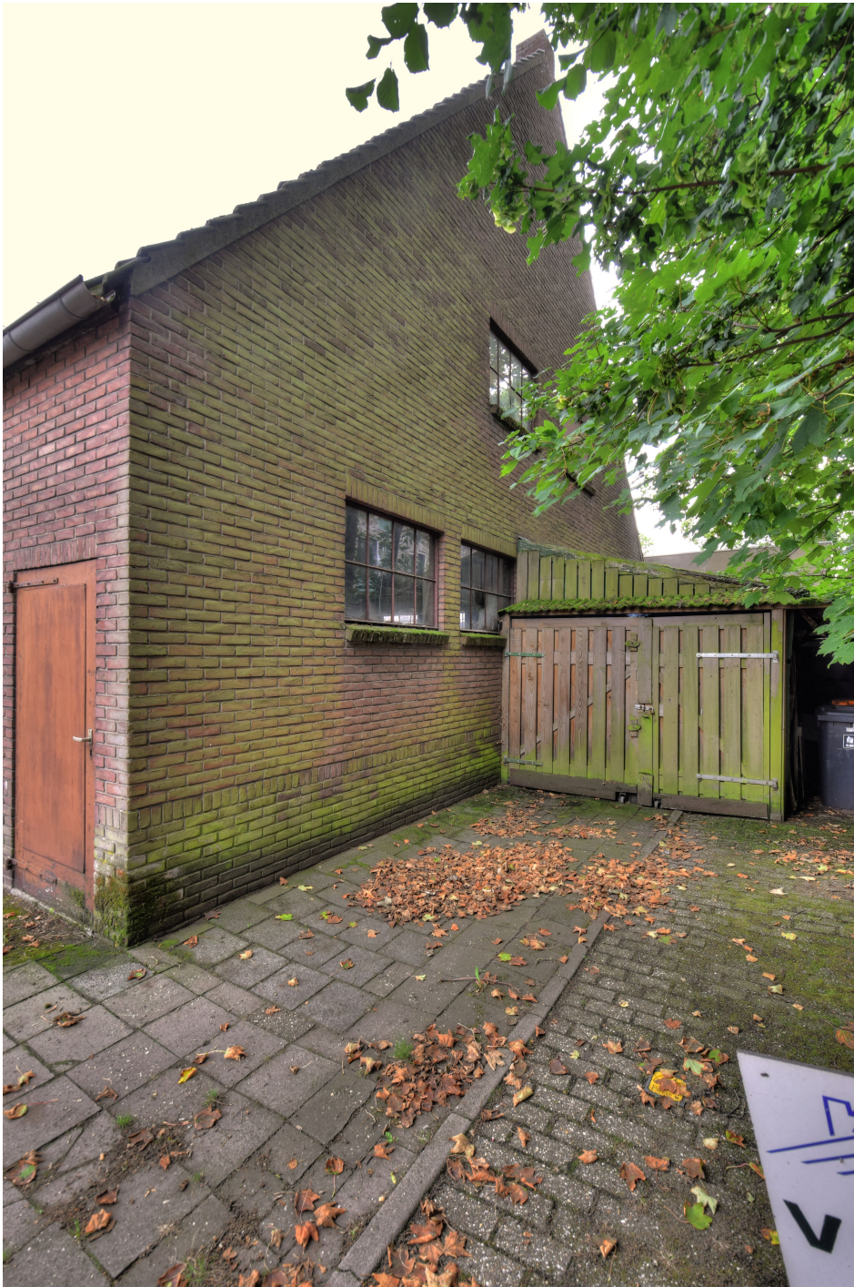
Overzicht van de achtergevel (westgevel).
