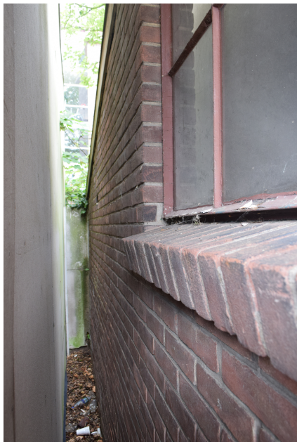
Detail van de linker zijgevel ter hoogte van de uitbouw.
