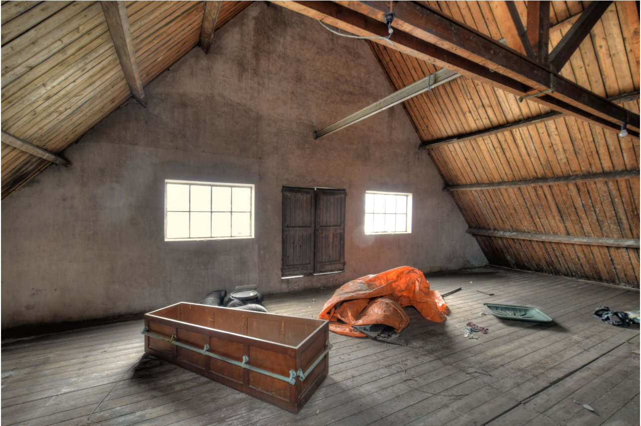
Overzicht van de voorzijde van de zolder met zicht op de binnenzijde van de dubbele hijsdeuren en de stalen hijsbalk. Op de voorgrond staat nog een oude (open) doodskist die op deze locatie vervaardigd zal zijn.
