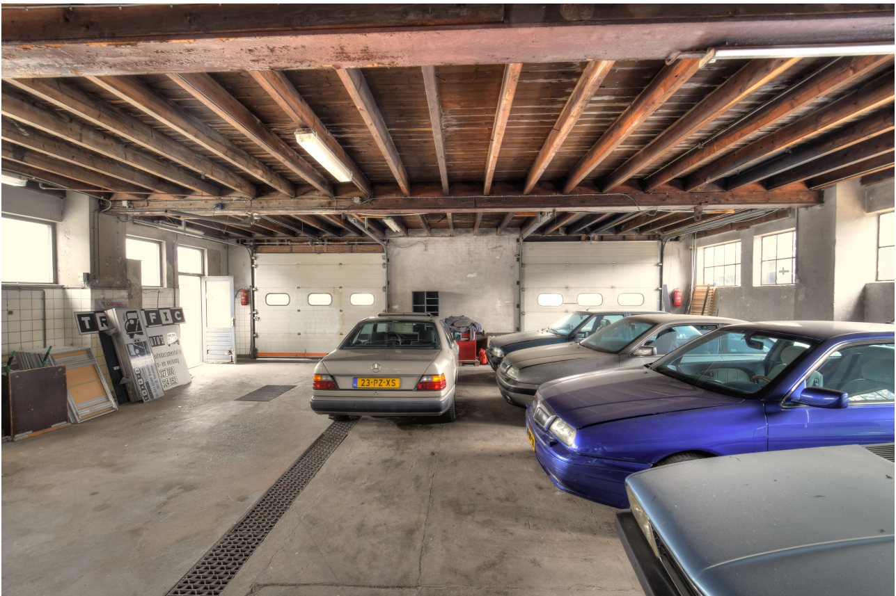
Begane grond van het gebouw in de richting van de voorgevel.
