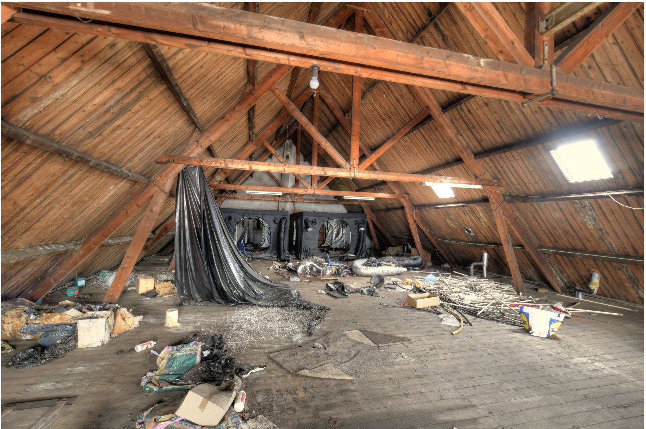
Overzicht van de zolder met kapconstructie richting de achtergevel.
