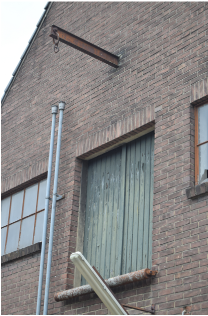
Detail van de hijsdeuren met hijsbalk in de voorgevel.
