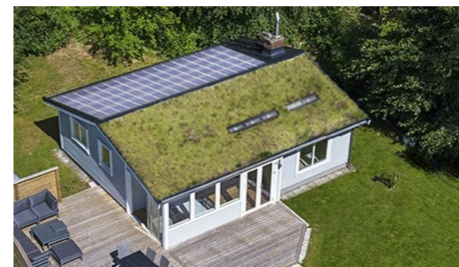
zonnepanelen i.c.m. groendaken
