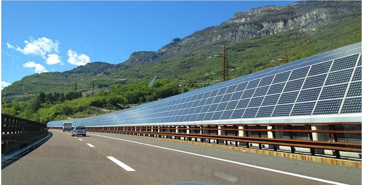
Afbeelding 9: Zonne installatie langs de "Brennerautobahn" in Italië
