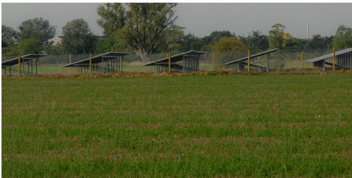
Afbeelding 29: Ter illustratie een zijaanzicht van panelen in een uitvoering voorgesteld aan de Bahrseweg te Wehl, hoogste punt 2,30 met 1,51m tussenruimte in de combinatie met een grofmazig gaashekwerk van 1,80m hoog. Voor het hekwerk komt ofwel een struweelhaag of een singel te staan.
