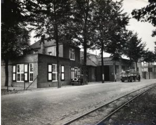
Foto van het complex van de Doetinchemse IJzergieterij omstreeks 1935. Op de voorgrond liggen aan de noordzijde van de Rijksweg nog de rails van de stoomtram, voorheen met aftakking naar de fabriek.
