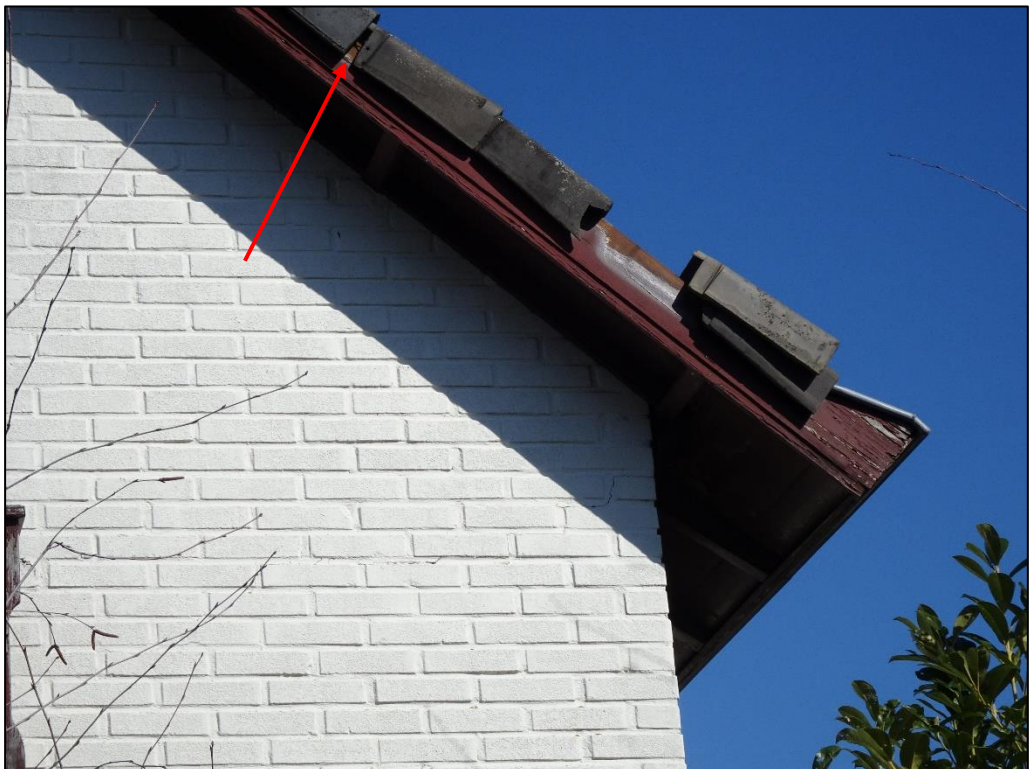
In de voormalige woning zijn meerdere mogelijkheden voor verblijfplaatsen van vleermuizen.
