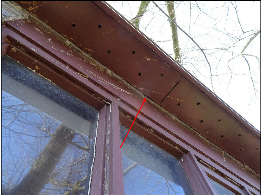
In het voormalige postkantoor zijn meerdere mogelijkheden voor verblijfplaatsen van vleermuizen.
