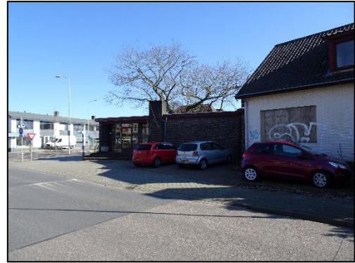
Het voormalige postkantoor grenst aan een woning.
