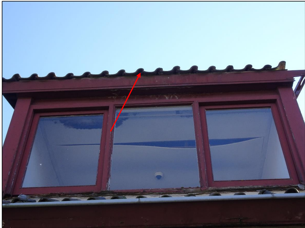
Dakranden van een dakkapel zonder dakgoot bieden de gierzwaluwen een goede mogelijkheid om onder het dak in te kunnen vliegen en een nest te bouwen.
