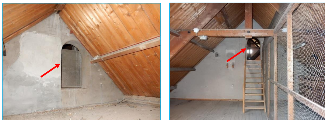
Foto's: Dicht te metselen toegang naar de zolders. (bron: EcoTierra).
