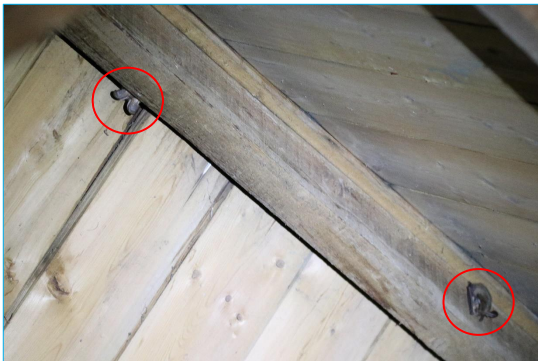
Foto's: Twee hangende gewone grootoorvleermuizen op de zolder van het filtergebouw (bron: EcoTierra).
